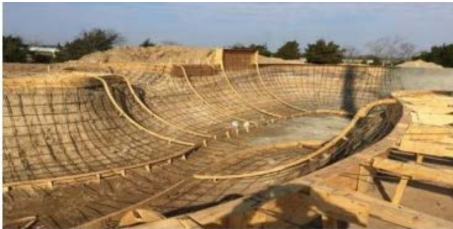
2 pav. Medinių klojinių montavimas.
